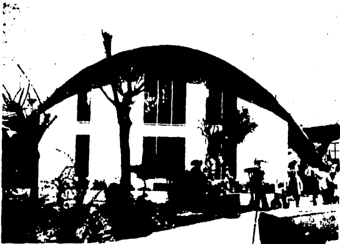
Fotografía No 10. Edificio de la Puerta de México.
