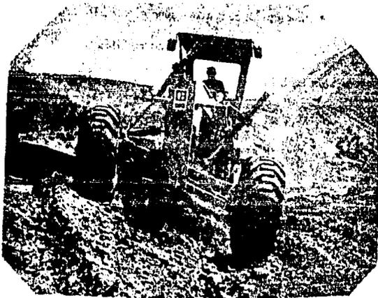
MOTOCONFORMADORA EMPLEADA EN TRABAJOS DE AFINE EN UN TERRAPLEN
