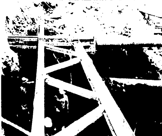
ALARGAMIENTO DE LOS BARRIOS. VISTA DEL TROQUE- LAMIENTO SUPERIOR.
