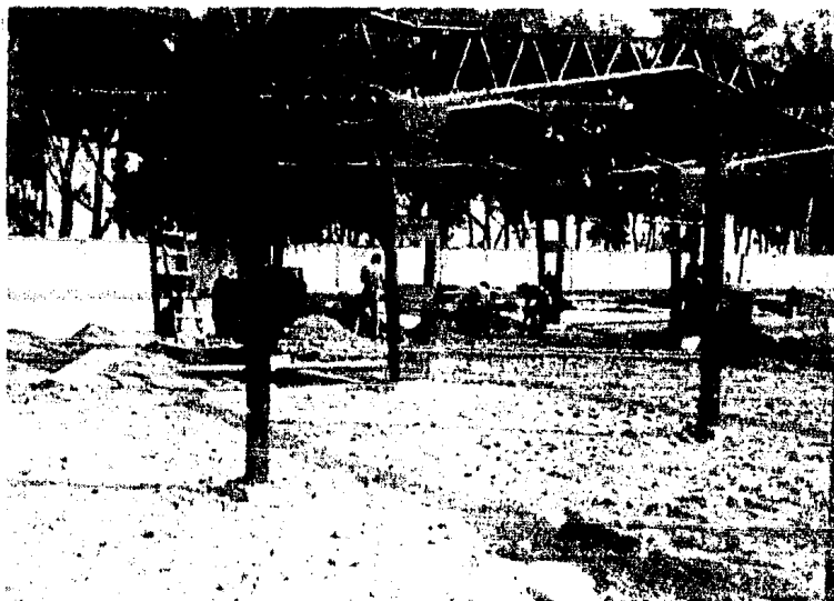
Fig.III.3.16.-Relleno de tepetate en oficinas.
