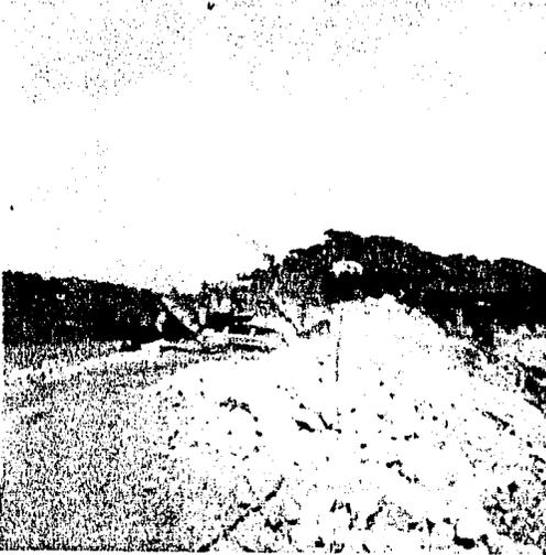
En la fotografía, se muestra la colocación del enrocamiento a volteo con un bulldozer D-8; el material fue extraído del banco "El chivo".
