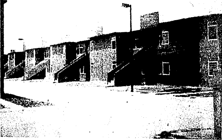
Módulos cuadruplex terminados. (Construidos con cimbra metálica)
