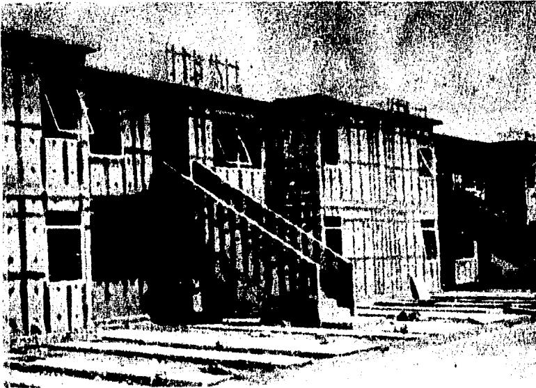
Terminación de obra negra.
