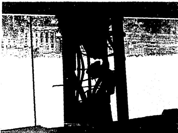
Foto 9.- Detalle del colapso de una columna debida al efecto de columna corta.
