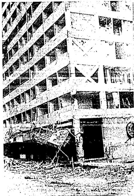
Foto 1.- Aspecto fachada principal-marco exterior contraventeado cuerpo sur edificio colapsado.
