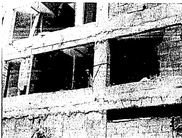
Fot 5.- Detalle, columna con falla frágil debida a la presencia del muro de concreto.
