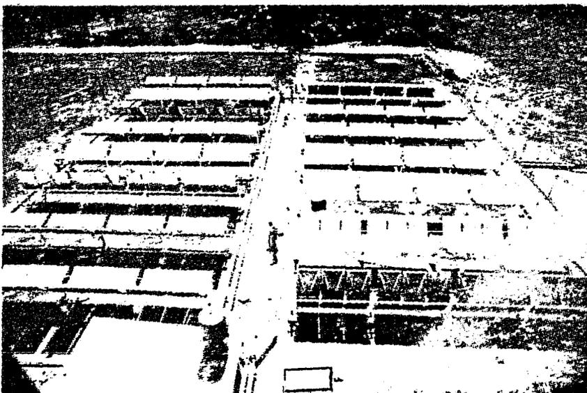
Fig 1.1 Módulos de los colectores solares de enfoque lineal
