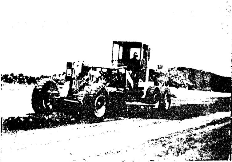
EL MATERIAL PARA REVESTIMIENTO DE CAMINOS DEBE SER HUMEDECIDO SEGUN SE VAYA EFECTUANDO EL TRABAJO DE LA MOTOCONFORMADORA, EL CUAL CONSISTE EN EL ACAMELLONAMIENTO, MEZCLADO, TENDIDO, CONFORMADO Y AFINADO.
