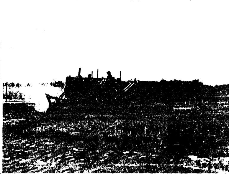
**CONCEPTO: EXCAVACION EN CUALQUIER MATERIAL, EN EL TERRENO NATURAL, PARA FORMAR LA CUBETA DEL CANAL.**
