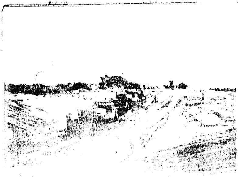
EXCAVACIONES EJECUTADAS CON MOTOESCREPAS CAT. MOD. 627 B
