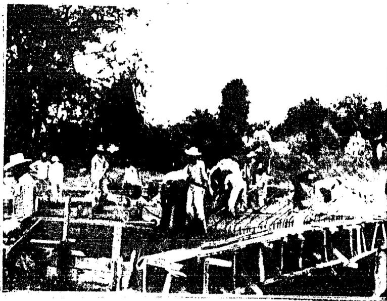
FABRICACION Y COLADO DE CONCRETO PARA LA LOSA DE UN PUENTE.
