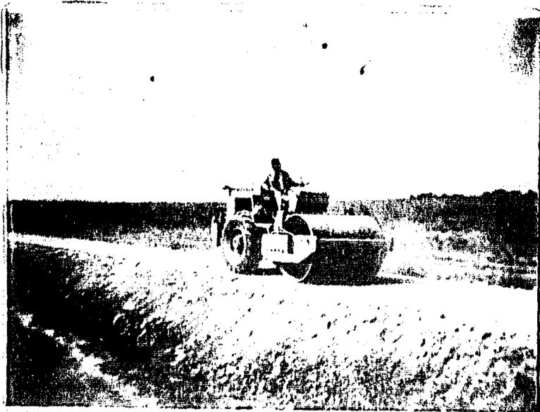
UNA VEZ EFECTUADAS LAS OPERACIONES DE LA MOTOCONFORMADORA, SE INICIA EL TRABAJO DE LA COMPACTACION. ES RECOMENDABLE EFECTUAR ESTA OPERACION CON RODILLOS LISOS VIBRATORIOS PARA UN MEJOR TERMINADO. EN ESTE CASO SE COMPACTA CON UN RODILLO LISO AUTO-PROPULSADO DYNAPAC MOD. CA-15.
