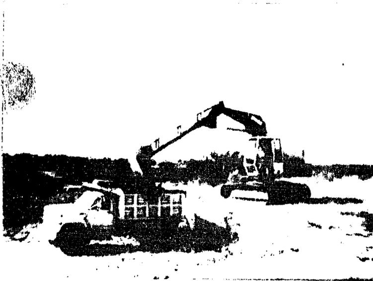
OPERACION DE EXTRACCION Y CARGA DE MATERIAL PARA REVESTIMIENTO DE CAMINOS, UTILIZANDO UNA RETROEXCAVADORA YUMBO MOD. 630-L. SE HACE LA OBSERVACION DE QUE ESTE EQUIPO SE PUEDE EMPLEAR COMO MAQUINA DE CARGAR CUIDANDO QUE EXISTA UN DESNIVEL ENTRE LA RETROEXCAVADORA Y LOS CAMIONES VOLTEO.
