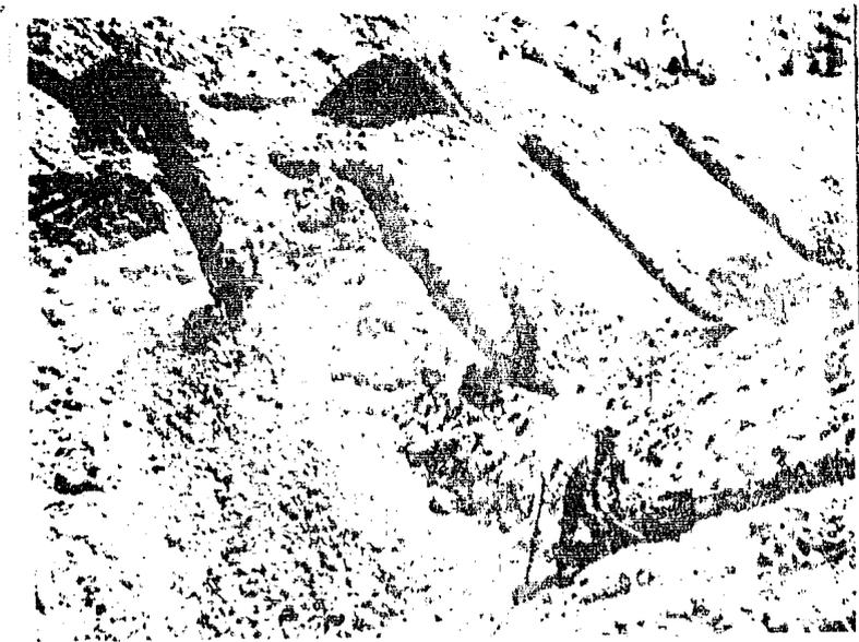
EXCAVACIONES Y AFINES A MANO PARA ALOJAR LAS ESTRUCTURAS. ESTA OPERACION REPRESENTA POCO VOLUMEN MOVIDO A MANO CON RELACION AL VOLUMEN TOTAL DE EXCAVACION DE LA ESTRUCTURA.
