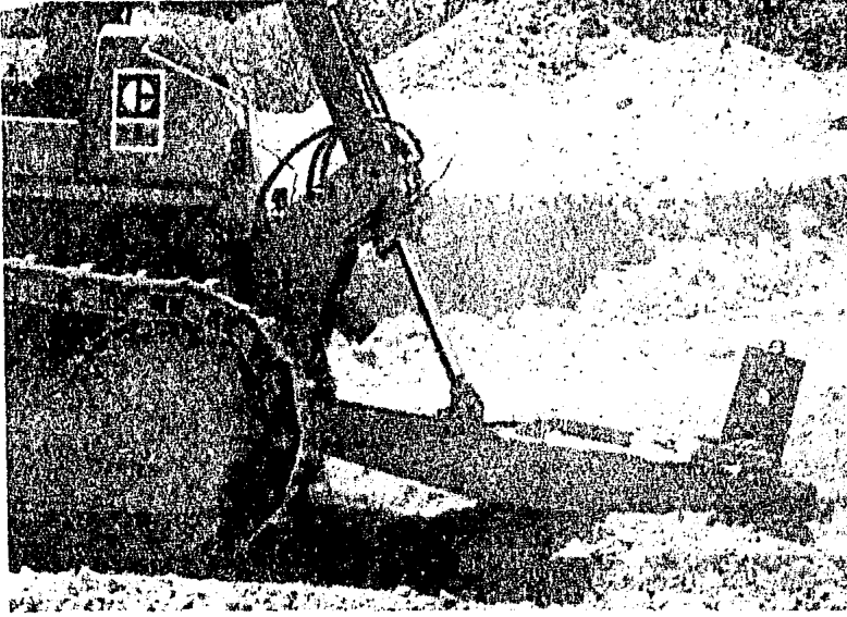
FIG. X.= Con el objeto de aflojar el terreno se Rippea con la parte posterior del tractor.
