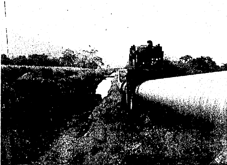
XL.= Tramo de tubería rasquetada, esmaltada y envuelta en donde se aprecia la máquina despues de un turno de trabajo.
