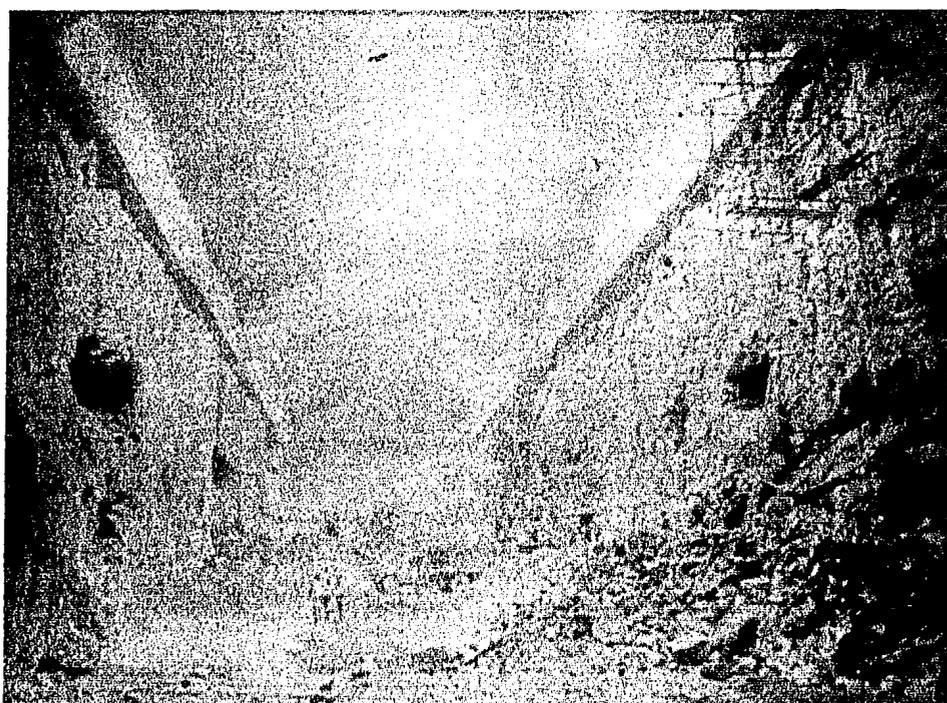
FOTO 4.4 Casa de máquinas, en proceso de construcción, del P.H. "El Caracol", en donde se puede apreciar la bóveda de concreto reforzado y las preparaciones para los rieles de la grúa viajera.
