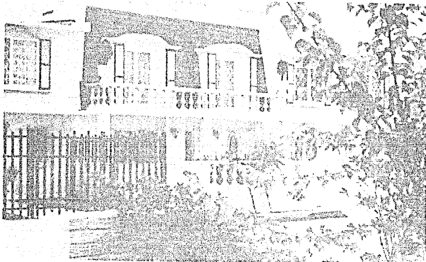
CASAS TERMINADAS CON EL SISTEMA STOUTBILT. LAS MARGARITAS. ( MEXICO )
