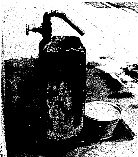
FIG.25(d) HIDRANTE PUBLICO SIN DRENAJE.
