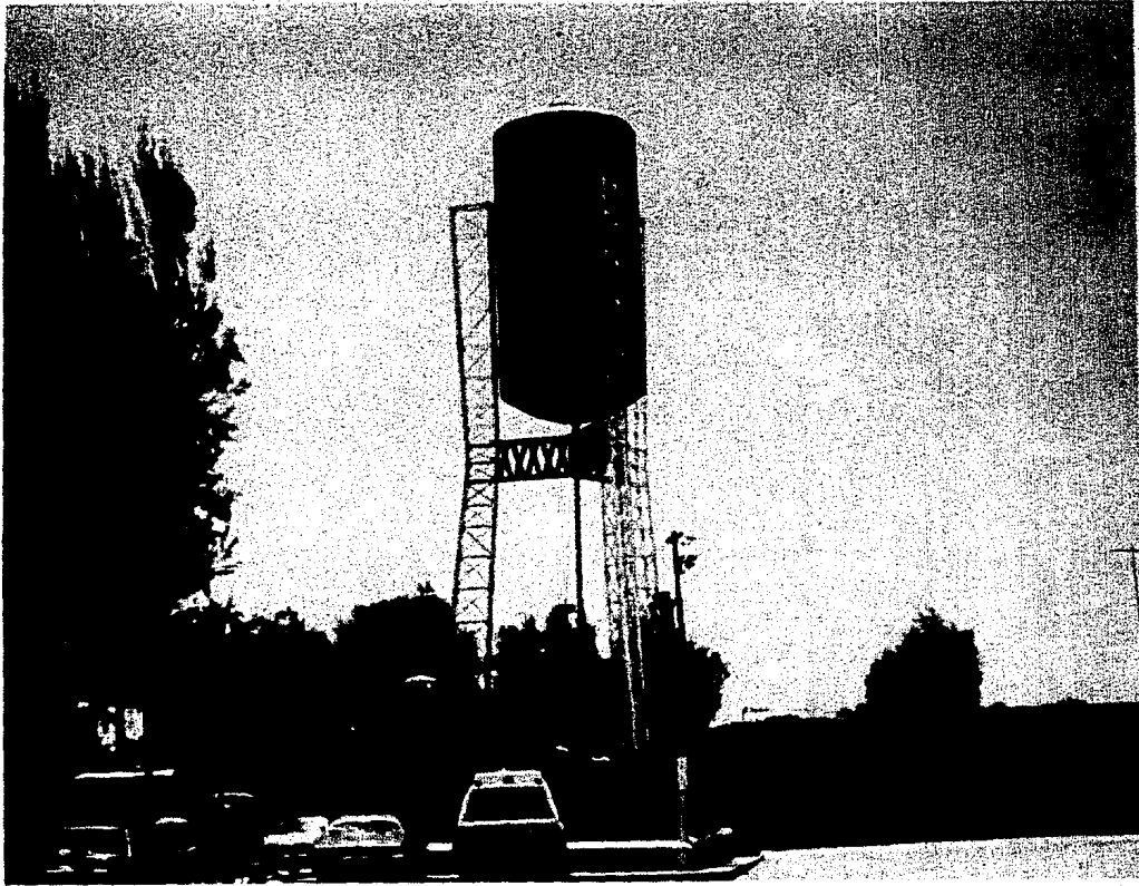
FIG. 28(b) DEPOSITO ELEVADO.
