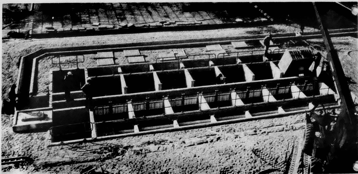
FIG. 3.11. DISTRIBUCION TIPICA DE CELDAS
