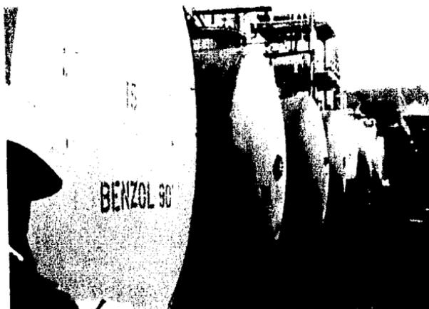
Batería de tanques de Almacén Iento de Benzono. Los tanques con una capacidad de 40 000 litros de Benzono, y en la foto se puede apreciar, el sistema de diques que cubre el área de Almacenamiento.
