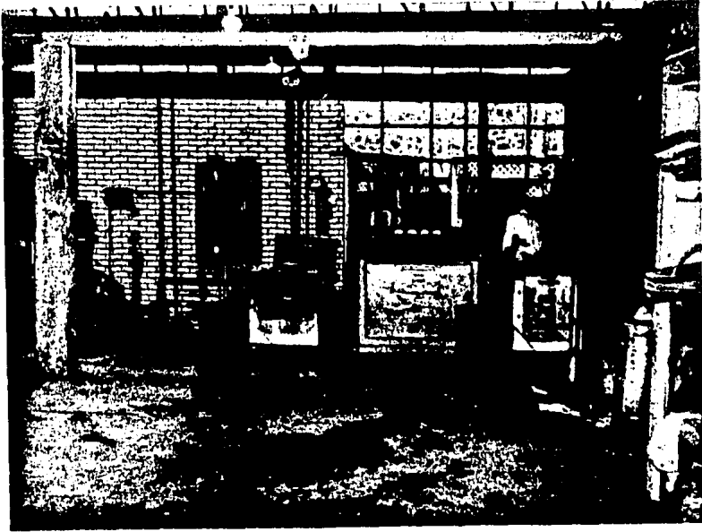
FIG. 16 Instalaciones del horno de inducción.
