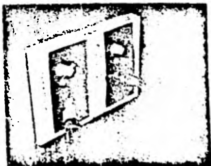
- Salidas de gases con acoplamientos rápidos.
