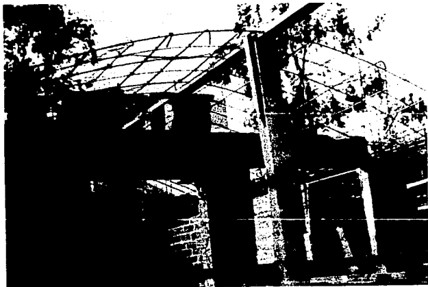
HABILITACION DE ACERO (ARMADO DE BOVEDA)
