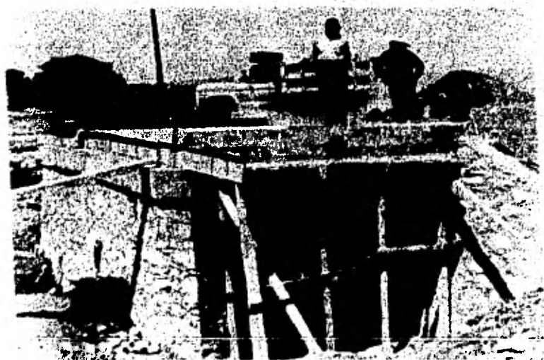
ALCANTARILLA DE MAMPOSTERIA
