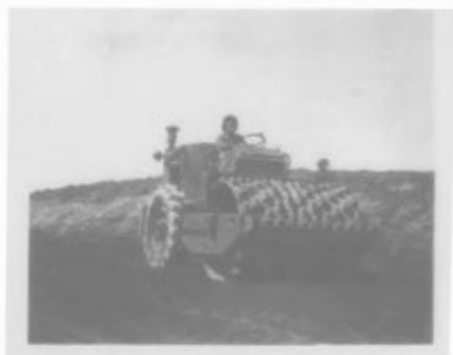
Fig. 10.8b. - Rodillo "cota de cabra" auto impulsado a vapor.
