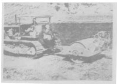
Fig. 10.14a.- Rodillo vibratorio sencillo y ligero remolcado por un tractor de oruga.
