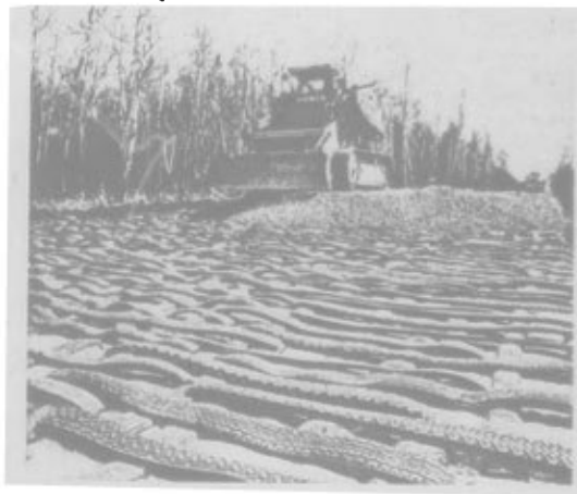
Fig. 13.1.- Una nueva y original forma de estabilización de suelos.
