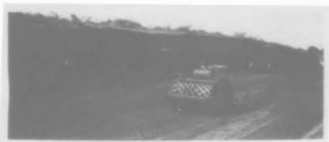
Fig. 10.8c. - Proceso de compactación de una capa de suelo utilizando un rodillo "cota de cabra".
