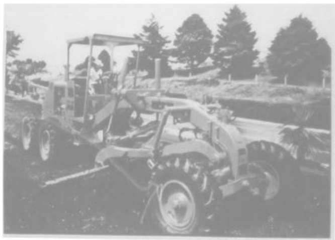
Fig. 10.6.- Hotoconformadora nivelando una base de suelo estabilizado.
