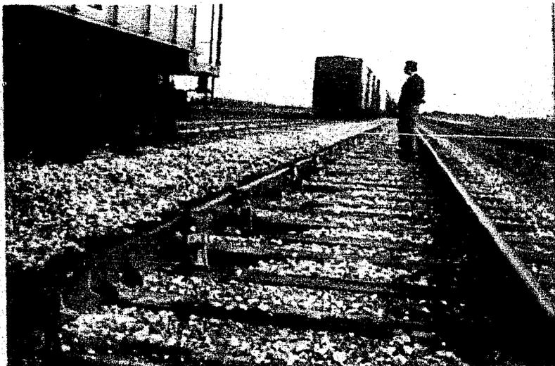
EN LA PRIMERA FOTOGRAFIA (a) SE MUESTRAN LOS RETARDADORES YA COLOCADOS EN LA VIA, Y EN LA SEGUNDA (b) SE MUESTRAN EN FUNCIONAMIENTO
