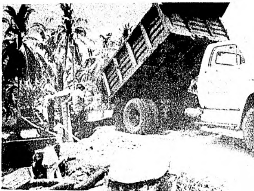
Foto No. 10 Alimentación de la planta.
