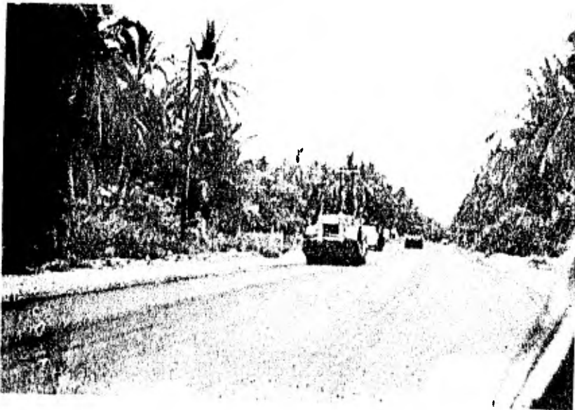
Foto No. 8 Compactación de Base asfáltica.
