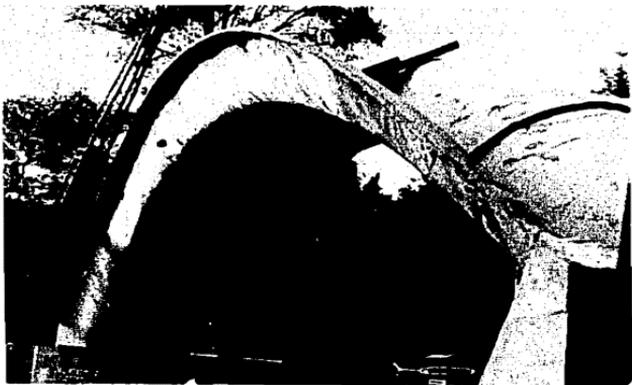
Foto 18 - Arco de ferrocemento con tensores de sujeción.
