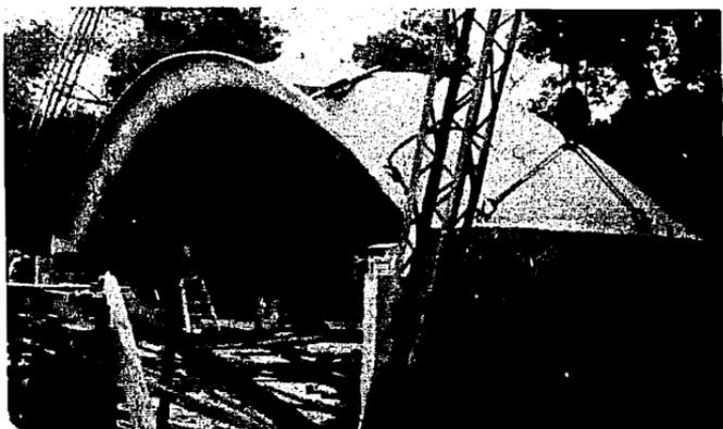
Foto 12 - Montaje de la cubierta en los muros de prueba, mediante pluma de carga.
