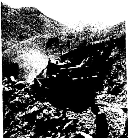
Tractor retirando el material producto de corte Km. 39 + 100
