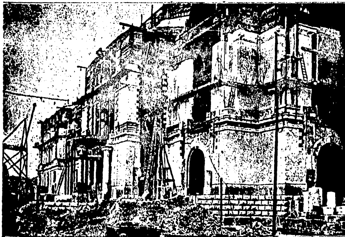
Aspecto de la fachada que ve al Ponfente
