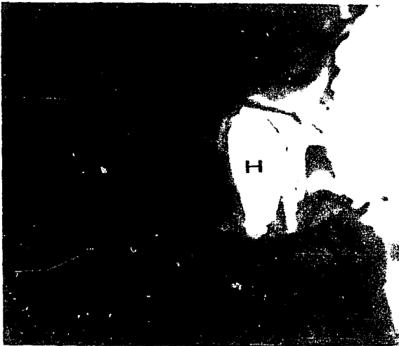
Figura 65. Hoyo producido por cavitación
