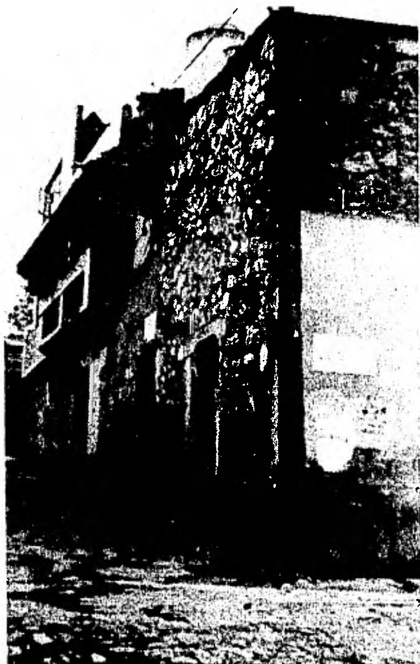
Vivienda de piedra y concreto en algunas de sus partes.
