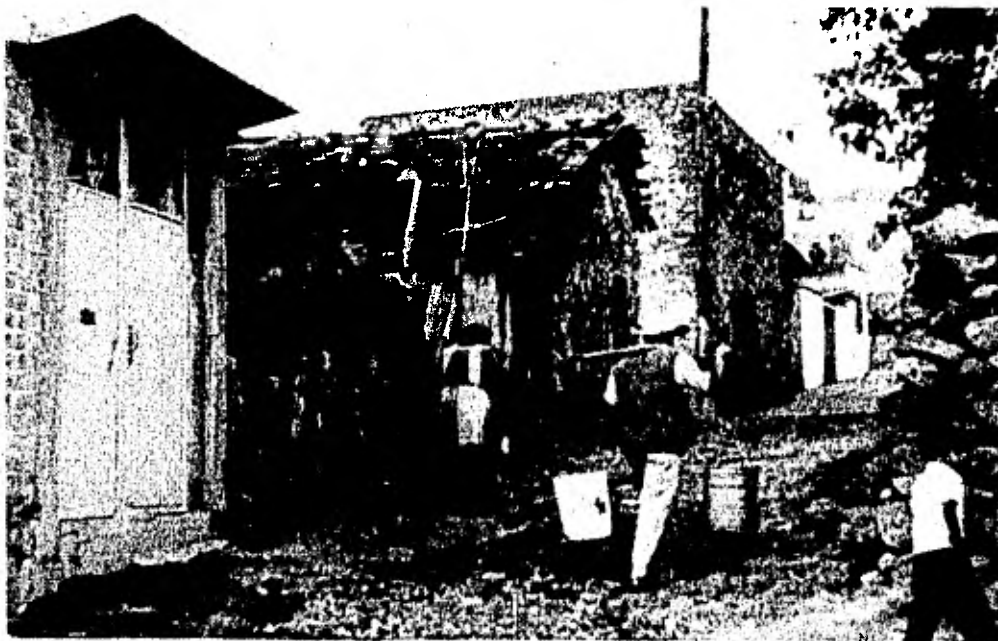
Calidad de la construcción BUENA y MALA en la calle Vicente Guerrero
