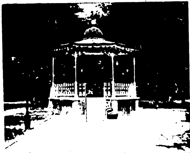
F-3). KIOSCO , ubicado en la Plaza 5 de Mayo.
