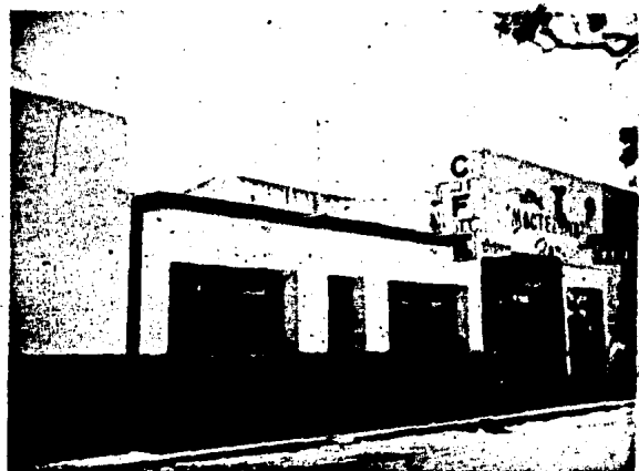
F25). OFICINA DE LA COMISION FEDERAL DE ELECTRICIDAD
